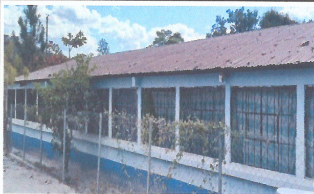
Foto 1: TECHO DE LAMINA
