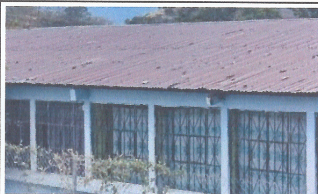
Foto 2: LAMINA DETERIORADA
